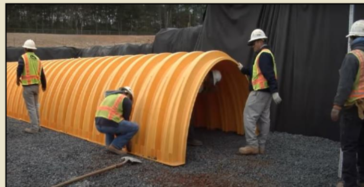
Figura 33.- Instalación del sistema con cámara MC-4500.
