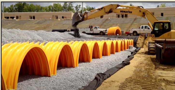
Figura 32.- Instalación del sistema.
