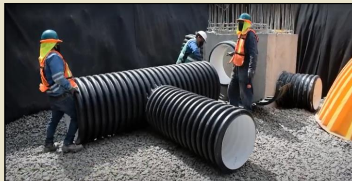
Figura 31.- Instalación de sistema en Vesta Industrial Park, Guanajuato.
