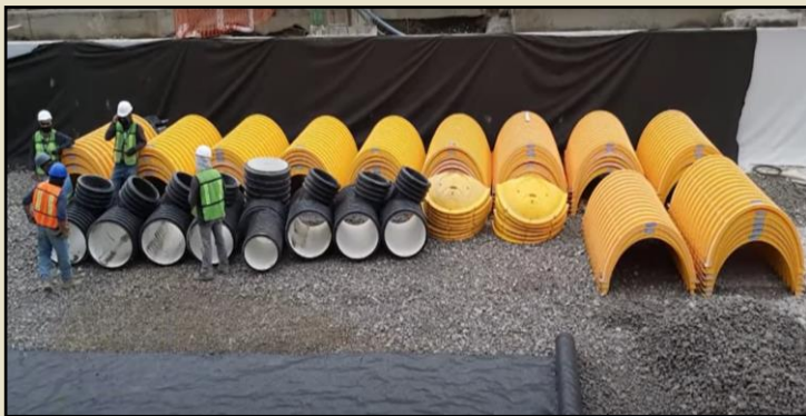
Figura 30.- Instalación de sistema en Toluca, Estado de México.
