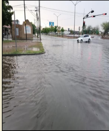
Figura 6.- Blvd. Juan Navarrete esquina con Blvd. Las Quintas
