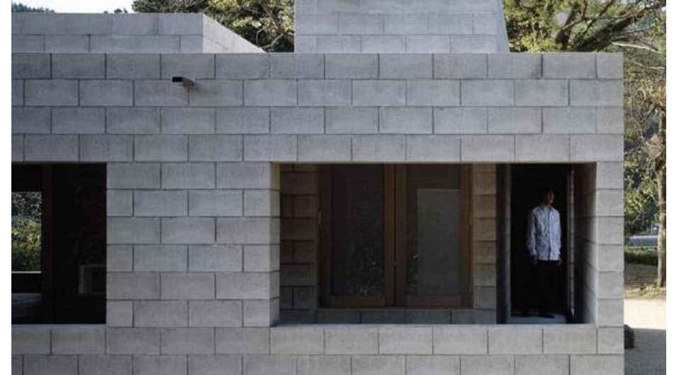
A base de block y cubierta de concreto armado.
